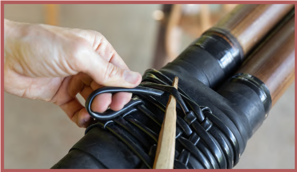
Detalhe de acabamento da amarra do tripé de bambu. Foto de Janine Moraes.
